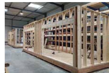
4. Assemblage des ossatures en usine
