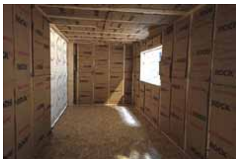
5. Pose de l'isolation, menuiseries et bardage
